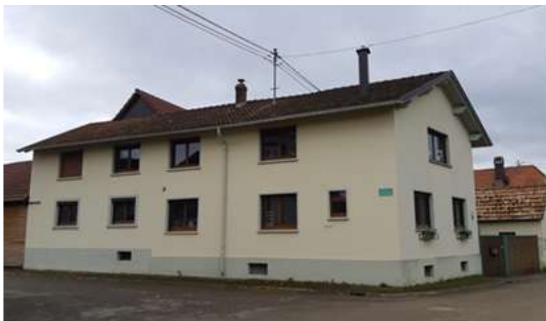
La maison d'habitation longeant la rue des Vergers.
