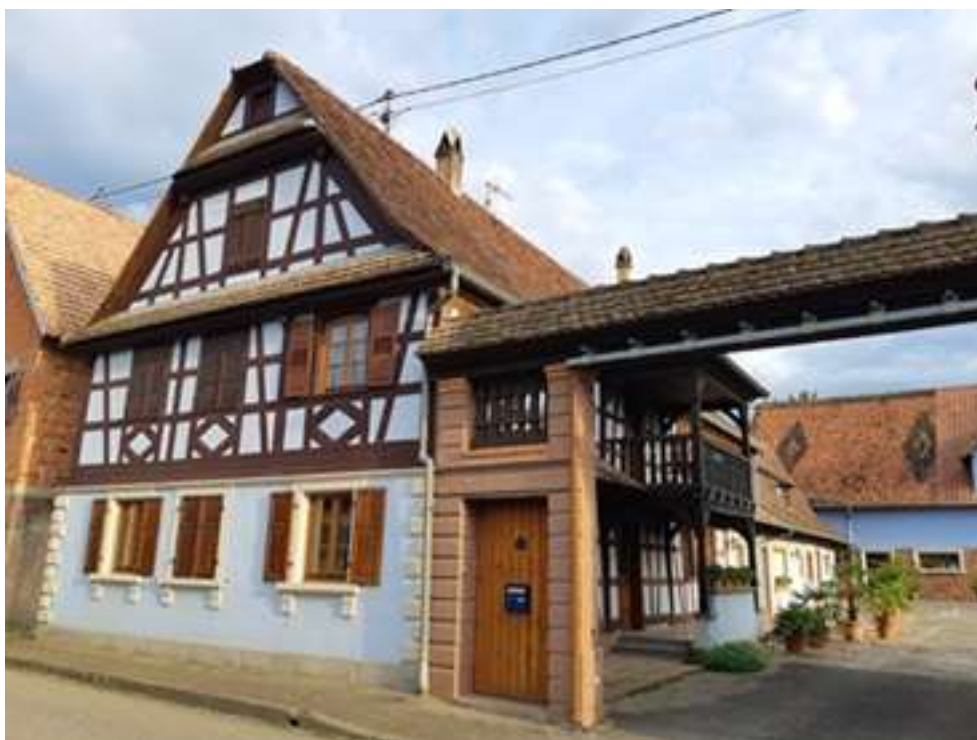
Vue générale de la maison d'habitation.
