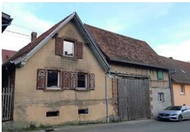
La maison avant sa rénovation.
